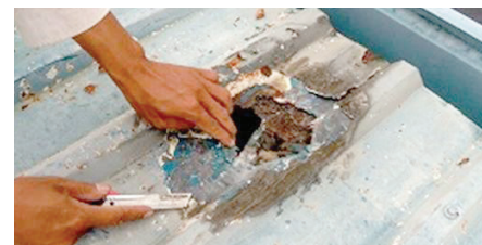
5年以上経過した屋根の状態 → 損傷が激しいため、雨漏りへ
