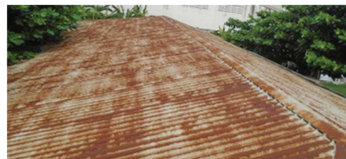
5年経過した屋根の状態 → 放置すれば、穴が空き、雨漏りへ
